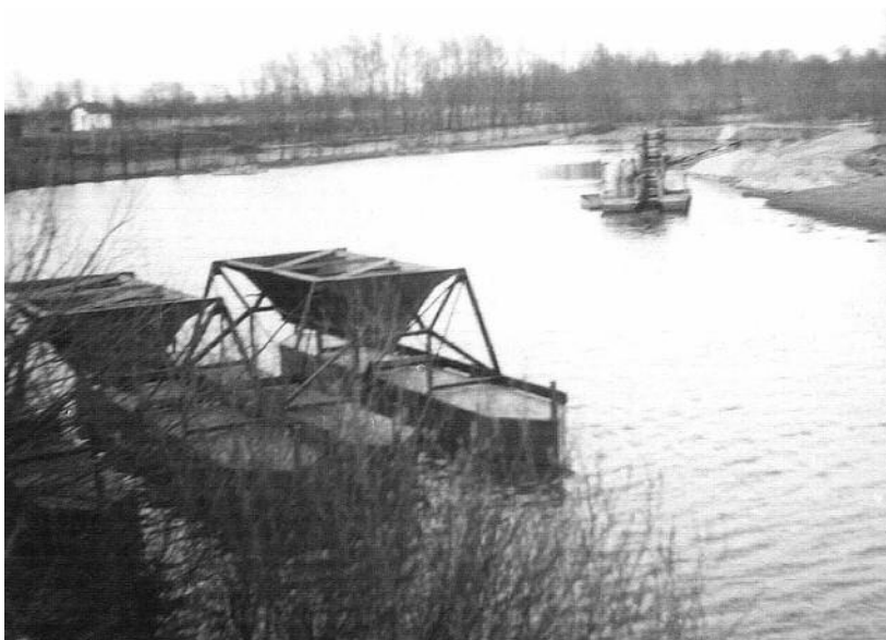
Rameno Uhliska před bagrováním - březen 1950.
