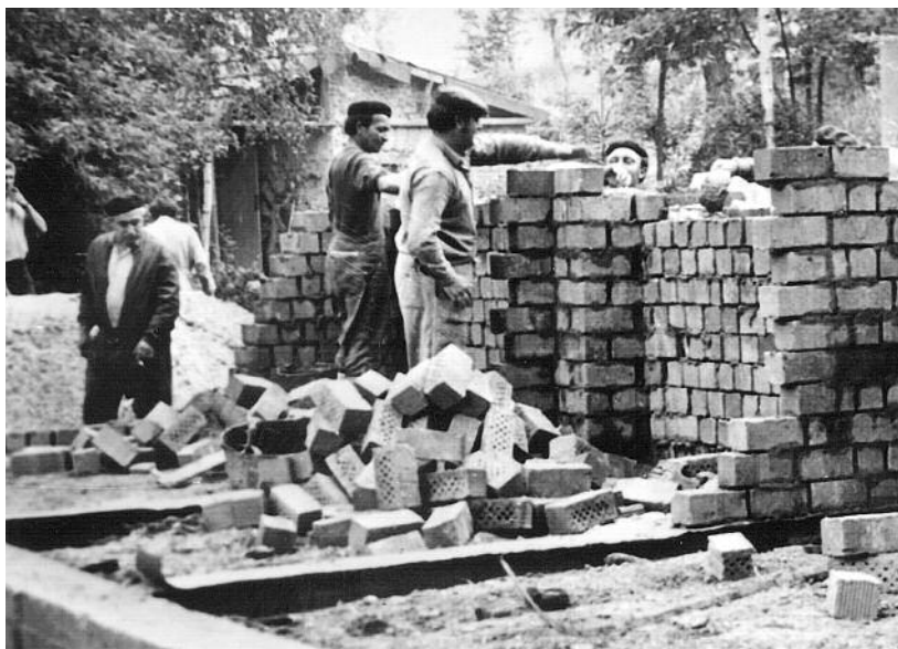
Zahájení výstavby hospodářského zařízení MO ČRS na rameni Uhliska - 1974.
