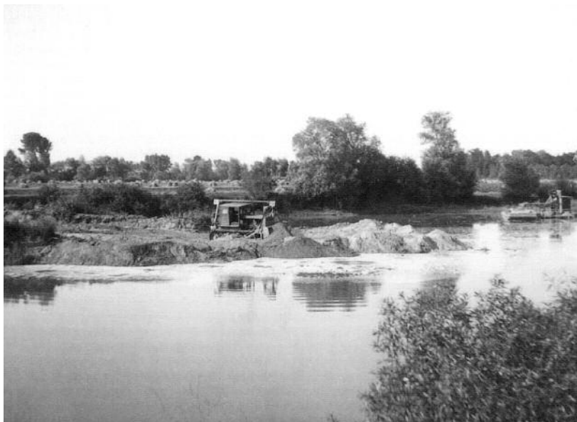
Buldozer dokončuje likvidaci ostrova na rameni Uhliska - srpen 1954.
