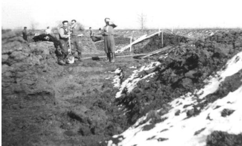
Jeden z úseků při výstavbě rybníku Svárov - 15. 3. 1953.
